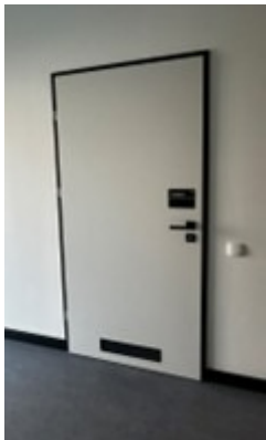
Zdjęcie 16 Pomieszczenie gospodarcze.
