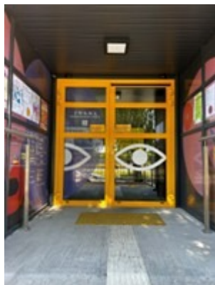
Zdjęcie 2 Drzwi automatyczne.
